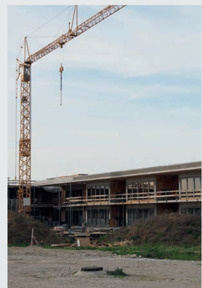
Der neue Kindergarten nimmt Gestalt an.
